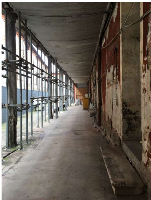
13. Il terrazzo in parte puntellato dell'edificio 291.
